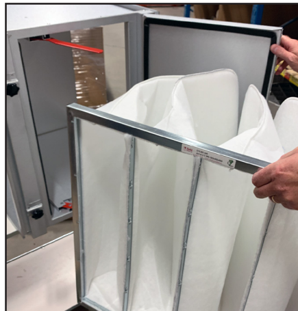
4. För in filtret i skåpet tills det tar stopp.
